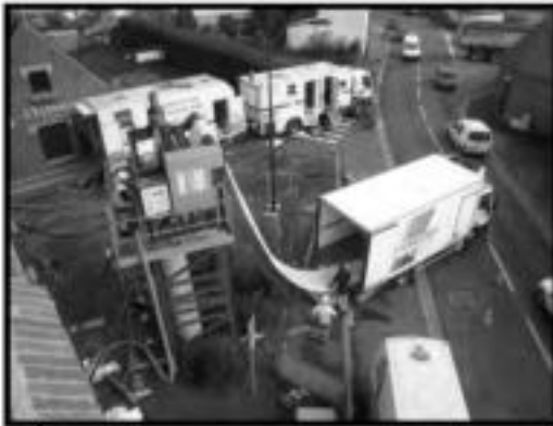
Travaux de réhabilitation par gainage continu à Arleux
