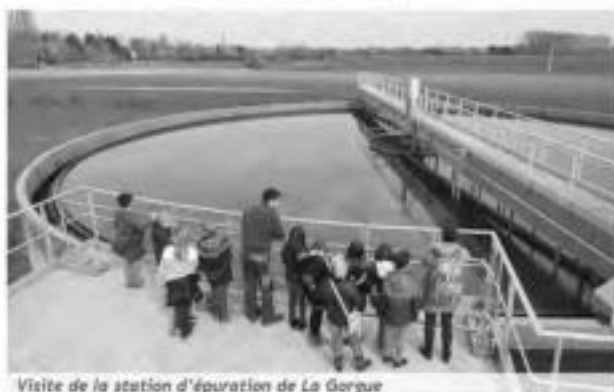
Visite de la station d'épuration de La Gorgue
