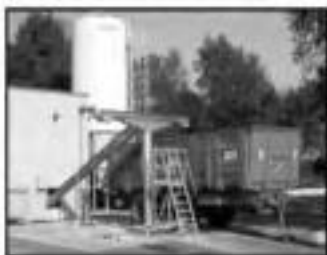
Extraction des boues STP Sin-le-Noble
